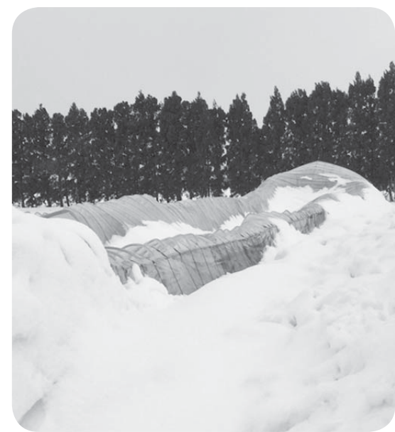
▲大雪で倒壊した農業ハウス
