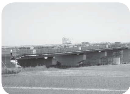
▲整備される道路 (金沢市)
